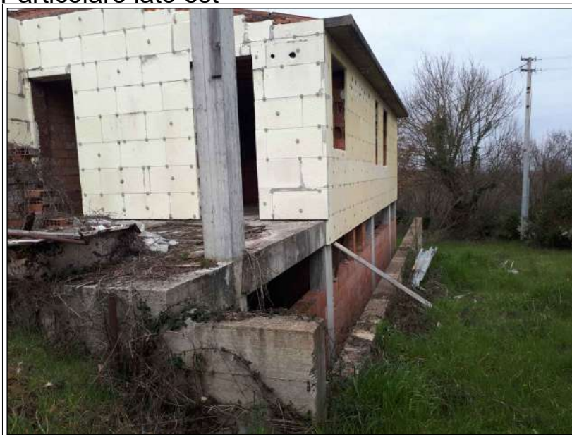
Particolare esterno lato est
