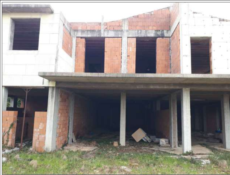
Particolare lato sud- est
